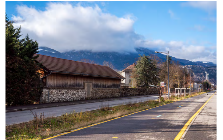
Avenue des Maquis de l'Oisans à Pont de Claix. L'espace est partagé entre la voie de circulation, la Chronovélo 3 et le trottoir.
