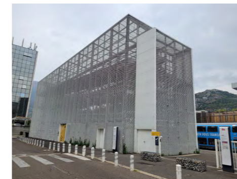
Le parking silo Ouest de la Gare de Grenoble peut accueillir 550 vélos.
