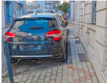
Trottoir trop étroit dans une rue de Voiron.
