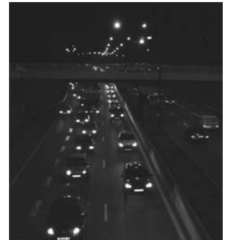
A480 Grenoble Pont du Drac
