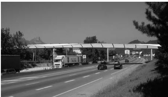
Passerelle piétons cycles Eybens Grenoble
