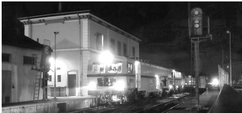
Les travaux de construction de la 3ème voie en gare de Gières ont débuté fin octobre 2006 et devraient durer jusqu'à la fin de l'été 2007. Photo : Jean-Marie GUÉTAT
