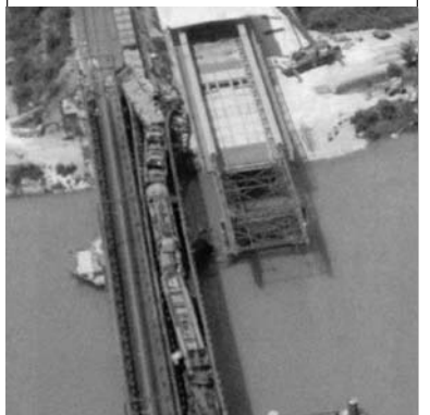
Déraillement en voie 1 de l'ancien pont. A droite, le nouveau pont en construction. Photo : laserman.free.fr/CulozPhotos
