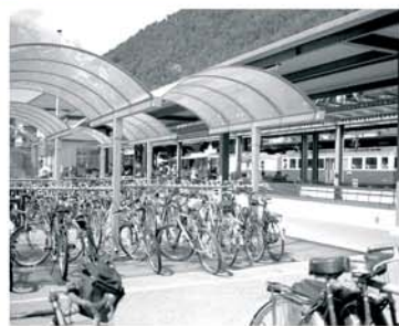
Les parkings-relais à Grenoble
