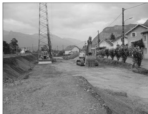
ble pour dégager la place des futures rampes. Ensuite seront coulés les murs de soutènement du saut de mouton, 80 mètres de chaque côté du pont et de part et d'autre de la future voie 2, encadrant une tranchée de 80 mètres pour le passage de la voie 2 Lyon. Le pont lui-même sera préfabriqué sur un des parkings de la gare de Moirans, puis amené en place par wagon, un peu comme ceux que nous venons de voir.
