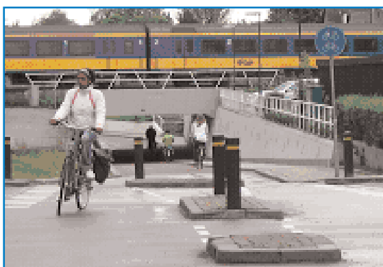
Carrefour dénivelé pour les vélos.
