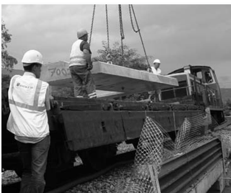
Pose d'un pont-rail lors du doublement de la voie en 2007
