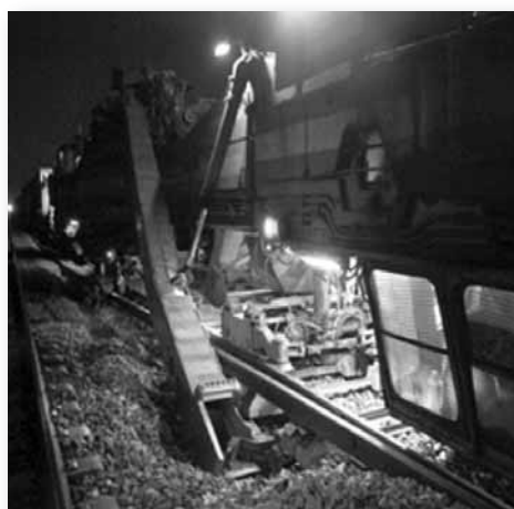
La dégarnisseuse. Au premier plan, le nouveau rail est déjà en attente.
