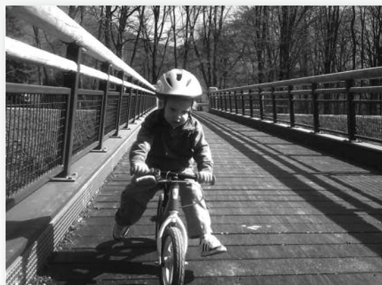
Passerelle de la Roize (2011)
