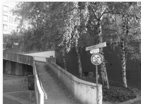
Rampe de la place Jean Moulin
