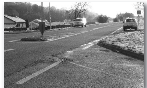
Un rétrécissement et un bout de trottoir dangereux...
