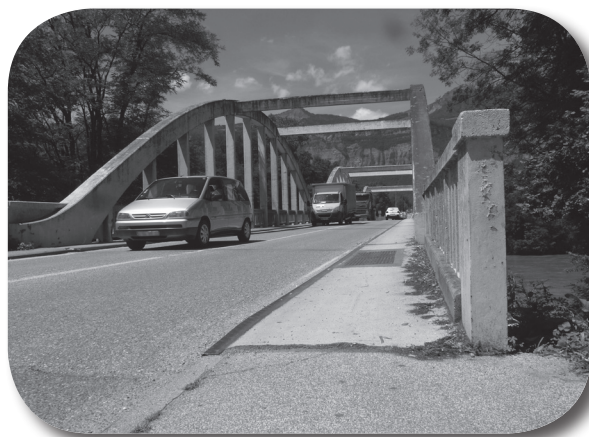
La nouvelle liaison Crolles-Brignoud va supprimer le passage dangereux du pont sur l'Isère et de la traversée de l'échangeur autoroutier. (Photo A.G.)
