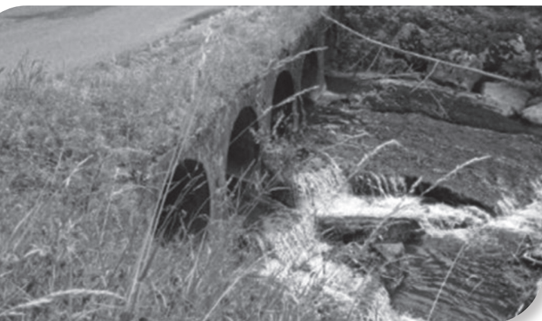
Le pont avec ses 4 buses sous la V63
